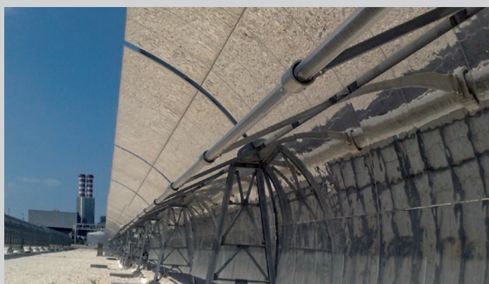
Progetto Archimede, Siracusa – sistema orientamento specchi per impianto solare
